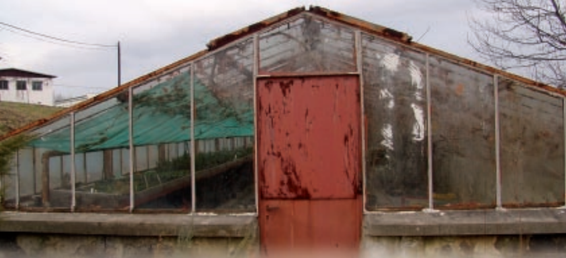
▲ Starý skleník před demolicí / Old green-house before demolition
